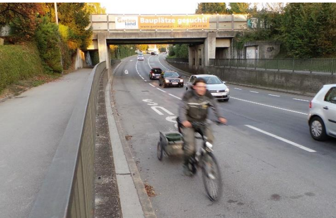
Busbeschleunigung L204/Unter der Bahn
